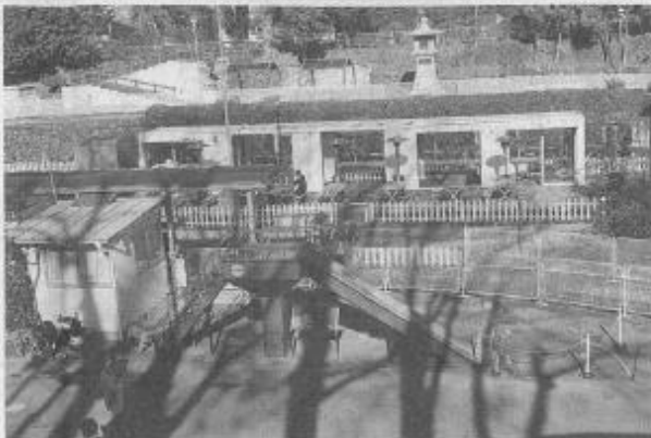
12フィート1台、20フィート1台のコンテナを連結させた
